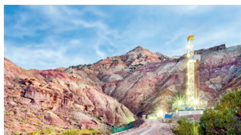
ガス収集・処理
